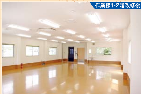
作業棟1・2階改修後
